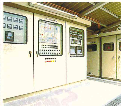
制御盤及び排ガスモニタリング装置 Control panel with exhaust gas monitor
