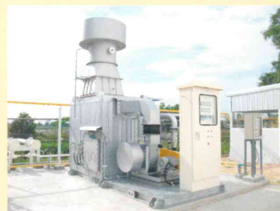
触媒燃焼式脱臭装置
