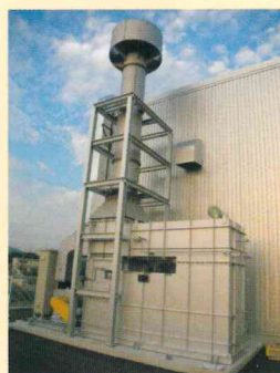
直接燃焼式脱臭装置
