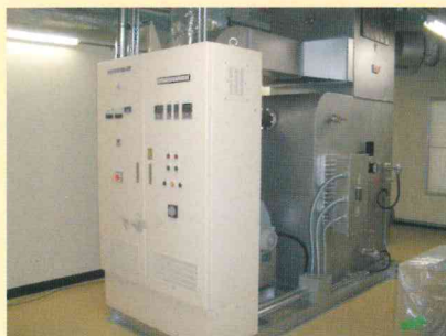
電気式触媒燃焼式脱臭装置
